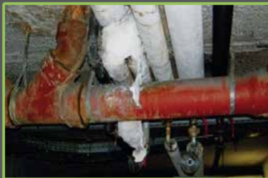
СЛИКА 23: Примена на азбестот: кровни покривки (слика лево) и водоводни цевки (слика десно)
