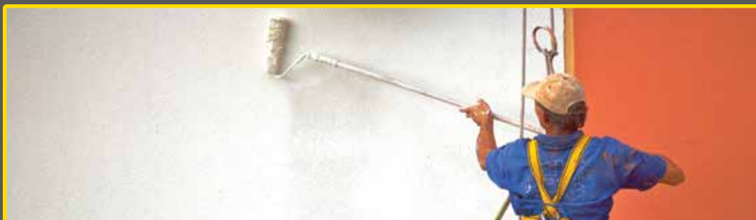
СЛИКА 10: Бојадисување на внатрешни ѕидови со завршен слој на боја
