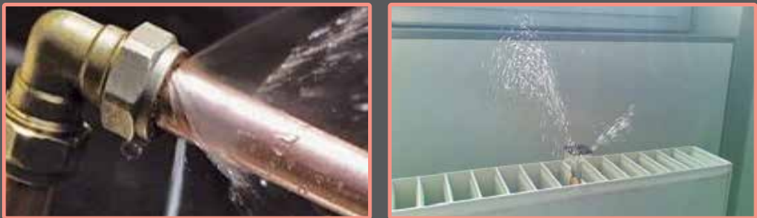
СЛИКА 21: Протекување на споеви и на радијатори
