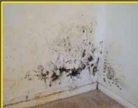
СЛИКА 9: Влажни дамки на тавани и ѕидови и нивно санирање
