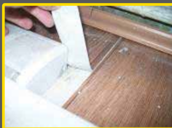
СЛИКА 13: Оштетувања на подовите од ПВЦ и на лајсните
