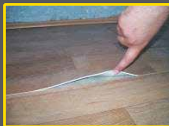
СЛИКА 13: Оштетувања на подовите од ПВЦ и на лајсните
