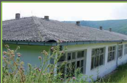
СЛИКА 23: Примена на азбестот: кровни покривки (слика лево) и водоводни цевки (слика десно)
