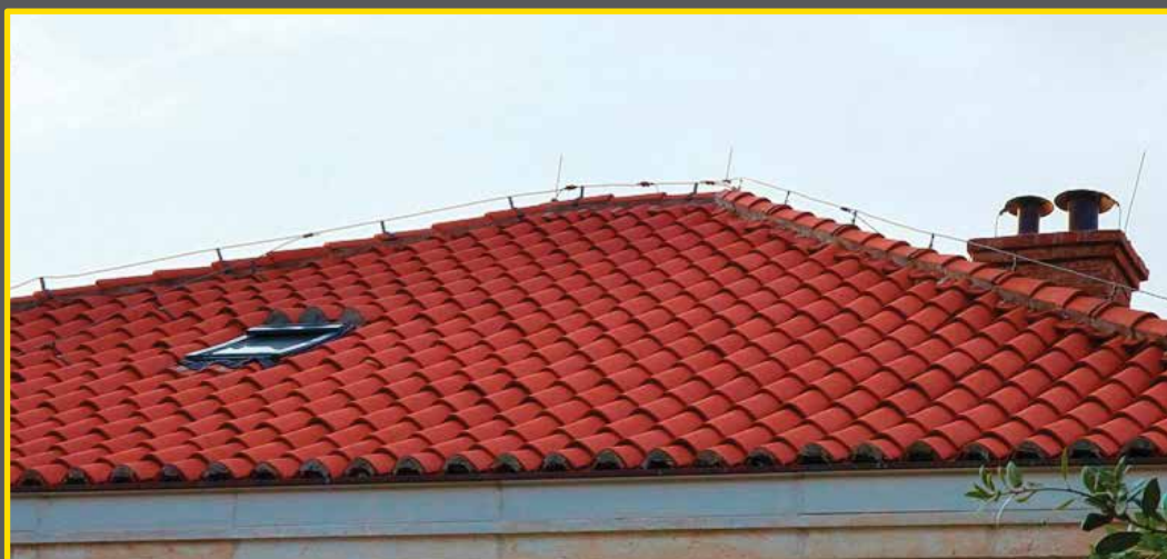
СЛИКА 6: Громобранска инсталација
