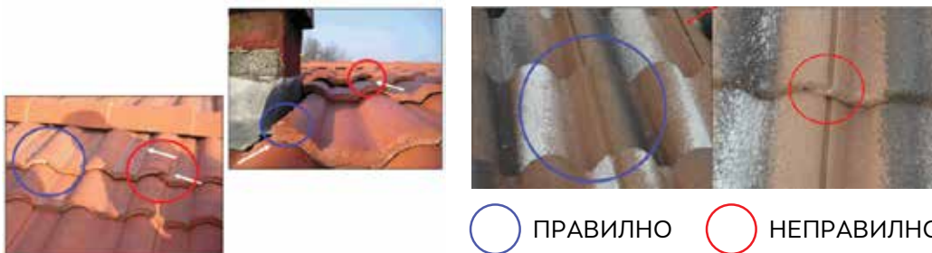
СЛИКА 4: Изведба на кровна конструкција
